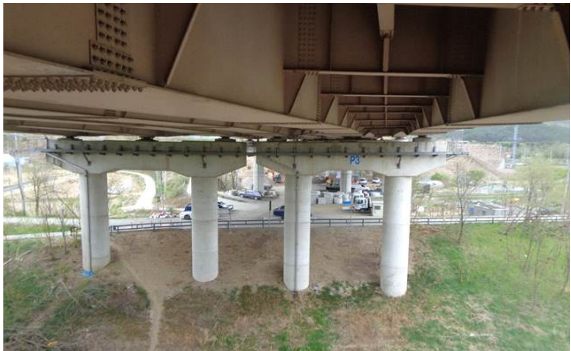
하부구조 전경 - 교각(P3)
